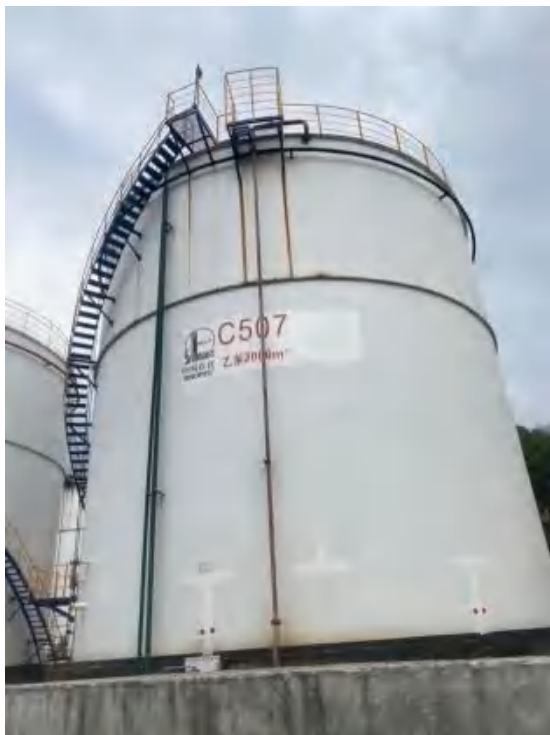
五号沟罐改乙苯罐
