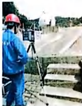
八号沟罐区罐区内 G1 (2023.06.14)
