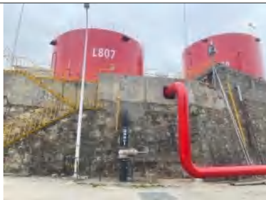
八号沟罐4个罐改消防水罐
