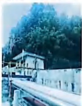
五号沟罐区内 G4 (2023.06.13)
