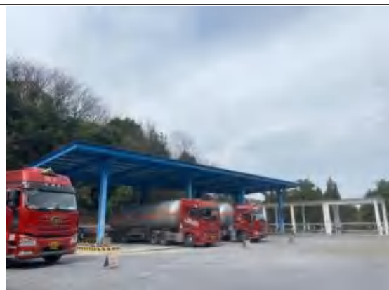
八号沟罐新建装卸栈台
