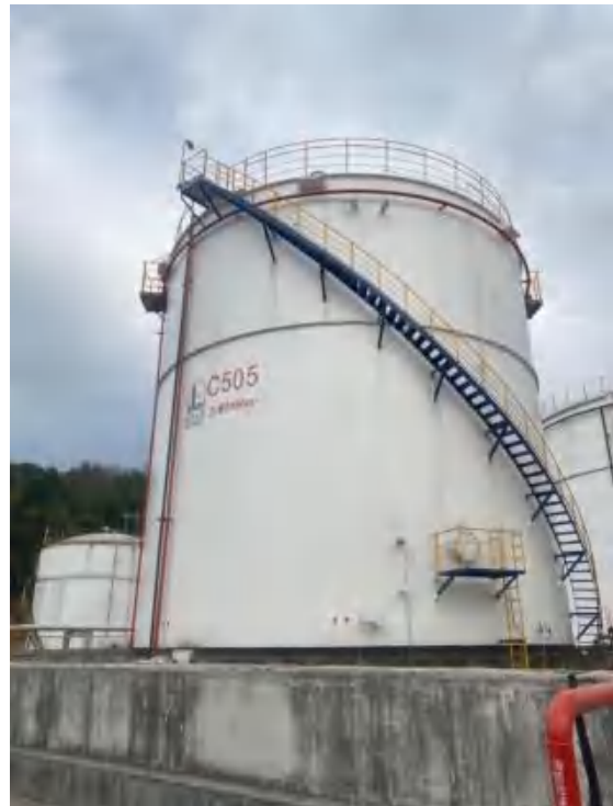
五号沟罐改乙苯罐
