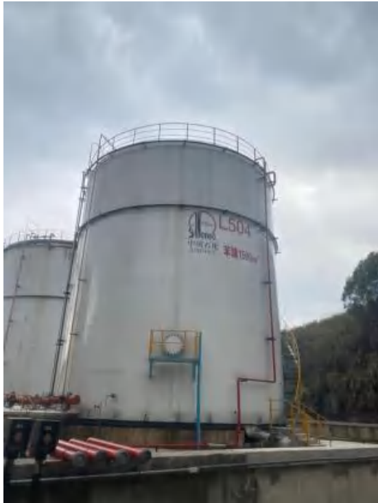
五号罐区新增苯罐
