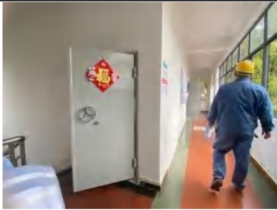
八号沟罐防爆门
