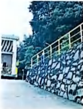
八号沟罐区罐区内 G1 (2023.06.13)
