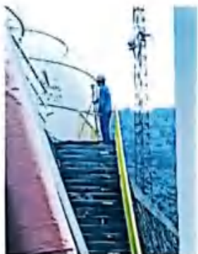
八号沟罐区罐区内 G2 (2023.06.13)
