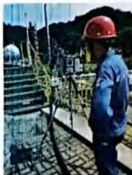
八号沟罐区罐区内 G2 (2023.06.14)
